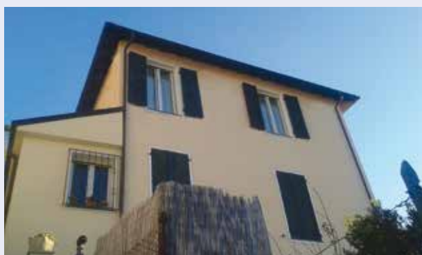
Facciata esterna di una palazzina ad Imperia
