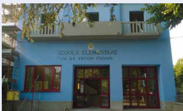
Facciata esterna di una Scuola a Paderno Dugnano (MI)
