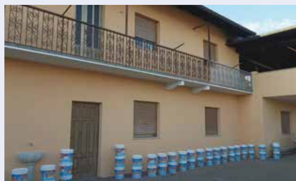
Facciata esterna di un'abitazione a Stroppiana (VC)
