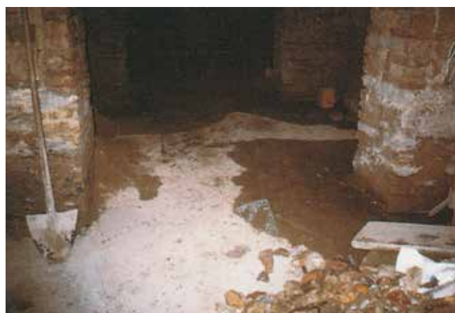
Foto n°1 - Cantina Senigallia (AN) - Prima dell'intervento
